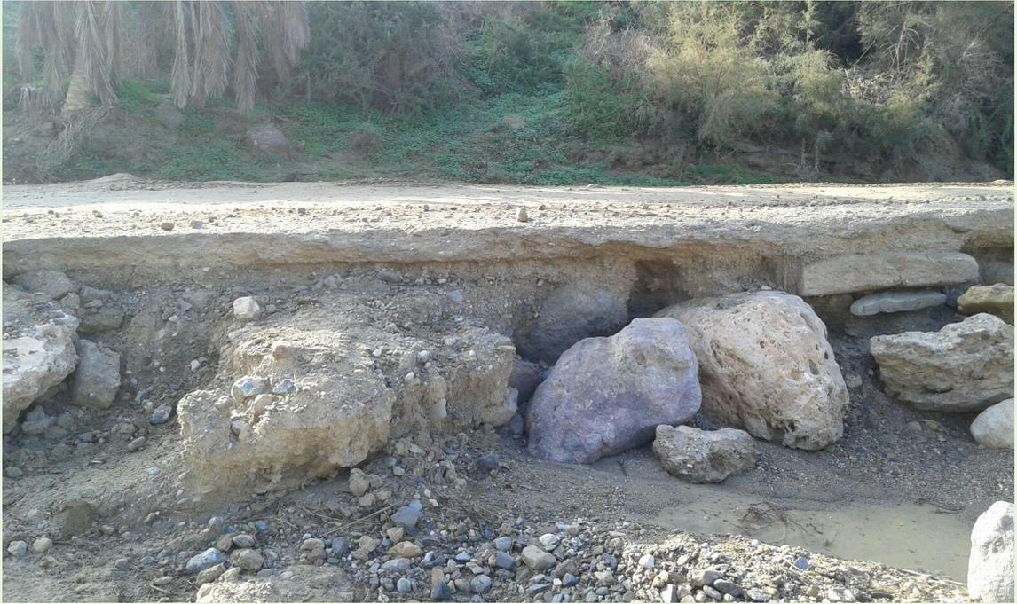
**Resistencia a la erosión hídrica de un camino tratado mediante estabilización.-Camino de La legión- (Almería).**
