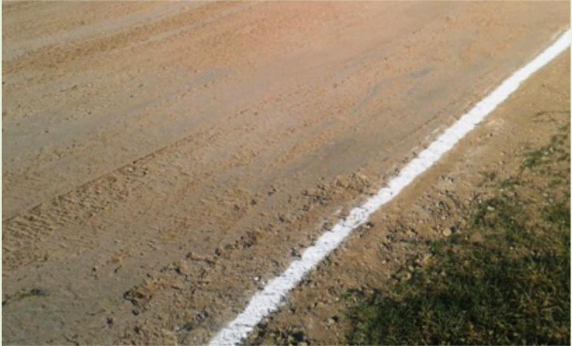
**Camino sin capa de rodadura tratado mediante estabilización.- Montmeló (Barcelona)**
